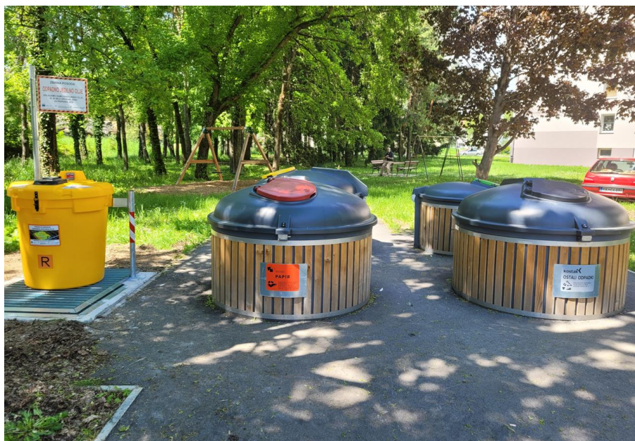
Slika 2: Podzemna zbiralnica za ločeno zbiranje odpadkov
