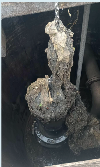
Zabite črpalke na kanalizacijskem črpališču, največ težav povzročajo vlažilni robčki.
