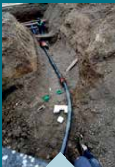
Obnove vodovoda potekajo skozi vse leto
