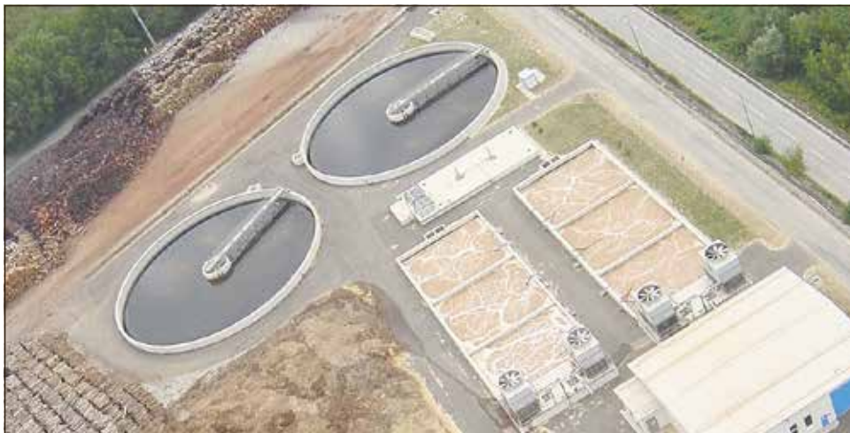
Čistilna naprava za čiščenje odpadnih voda podjetja Vipap Videm in mesta Krško (foto: Vipap)
